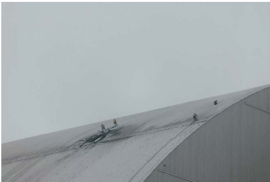
Beschädigte Schutzhülle in Tschernobyl, Ukrainischer Katastrophendienst 2025
